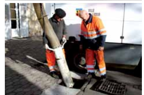
• Photo 1 : les 2 balayuses mécaniques
